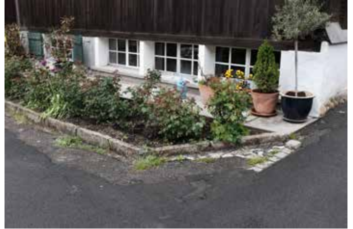
Vorbereich Haus 1619. Betonvorbereich gegossen ca. 93 cm breit, Garten mit Naturstein abgegrenzt.
