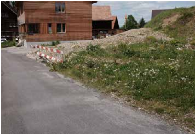
Fragmentierter Übergang zur Baustelle der letzten beiden geplanten Neubauten.
