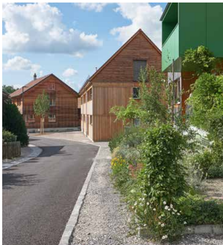
Die Gießenstrasse im Sommer 2020. Noch fehlt der Deckbelag.
