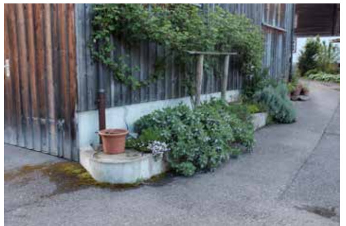
Gestaltung Vorbereich Gebäude 1634.
