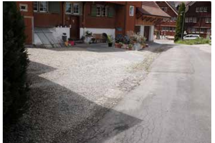
Bekiester Vorbereich ehem. Käsereigebäude.
