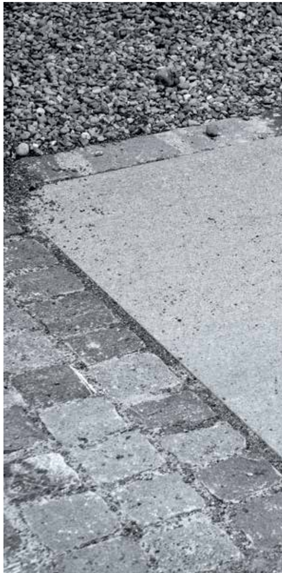
Zusammenspiel der Materialien: Kleinpflasterung, Natursteinplatte, Kiesfläche
