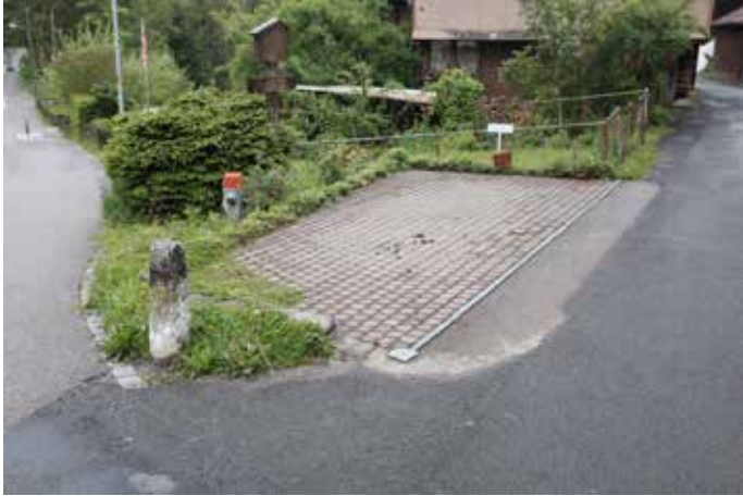
Einmündung in die Columbanstrasse, alter angeschnittener Poller, Parkplatz mit farbigen Verbundsteinen.
