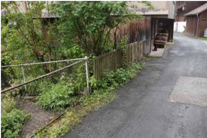
Gartengrundstücke 1138 und 1137. Betonsteine und Mauer grenzen die etwas tiefer liegenden Gärten ab. Fragmentarischer Strassenrand.
