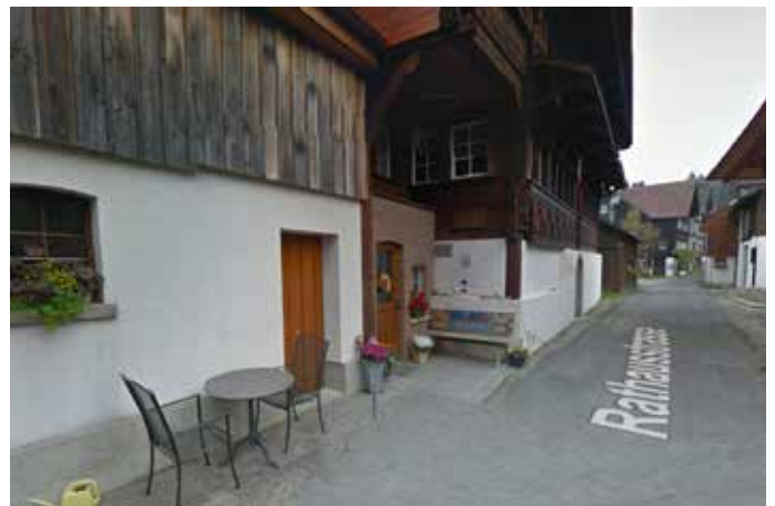
Gebäude 1629 und 1630. Im Vordergrund bilden private Reihenpflasterungen den Abschluss, beim Wohnhaus Bitumen bis ans Gebäude.
